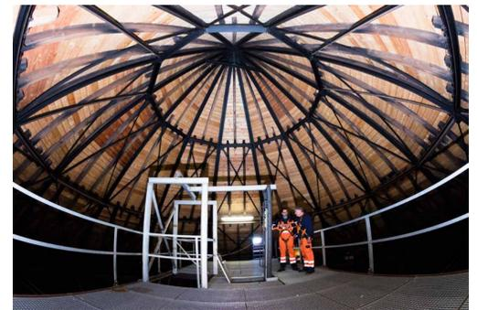
Der Behälter ist oben offen und nur durch eine Stahlkonstruktion sowie das Dach überdeckt. Zur Wartung des Wasserspeichers müssen die Mitarbeiter der Leipziger Wasserwerke über eine Leiter durch den elf Meter langen, schmalen Schacht aufsteigen.
