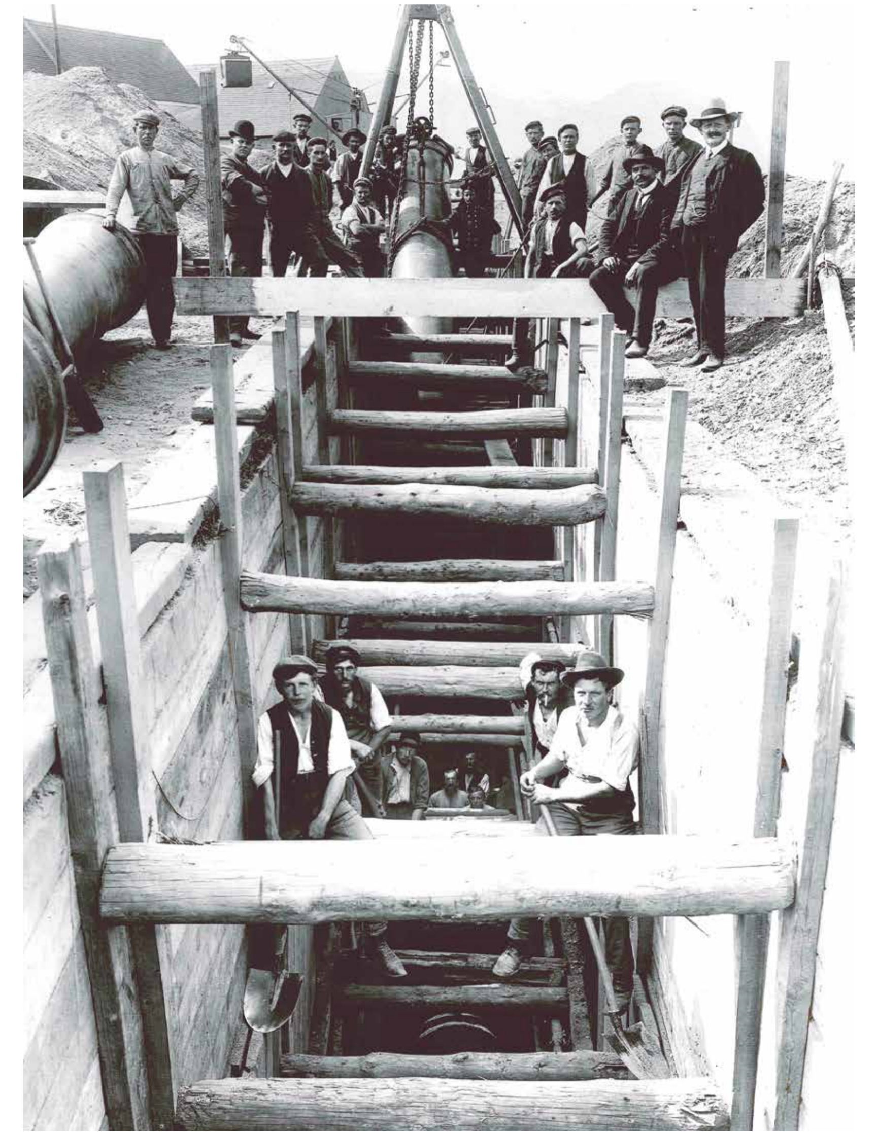
Bau der Fernleitung von Canitz nach Leipzig, um 1911
